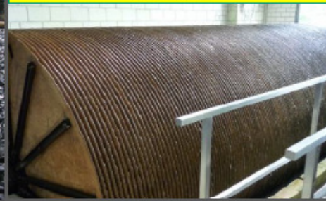
ROTOR BIOLÓGICO CONTATO BIODISCO
